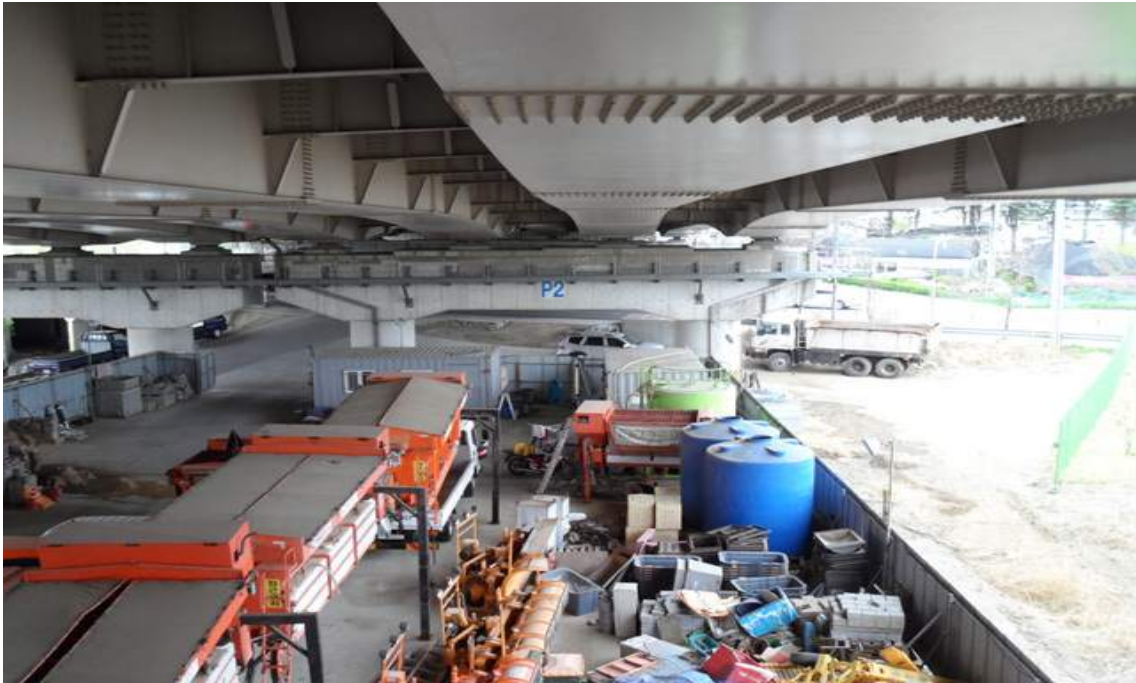
하부구조 전경 - 교각(P2)
