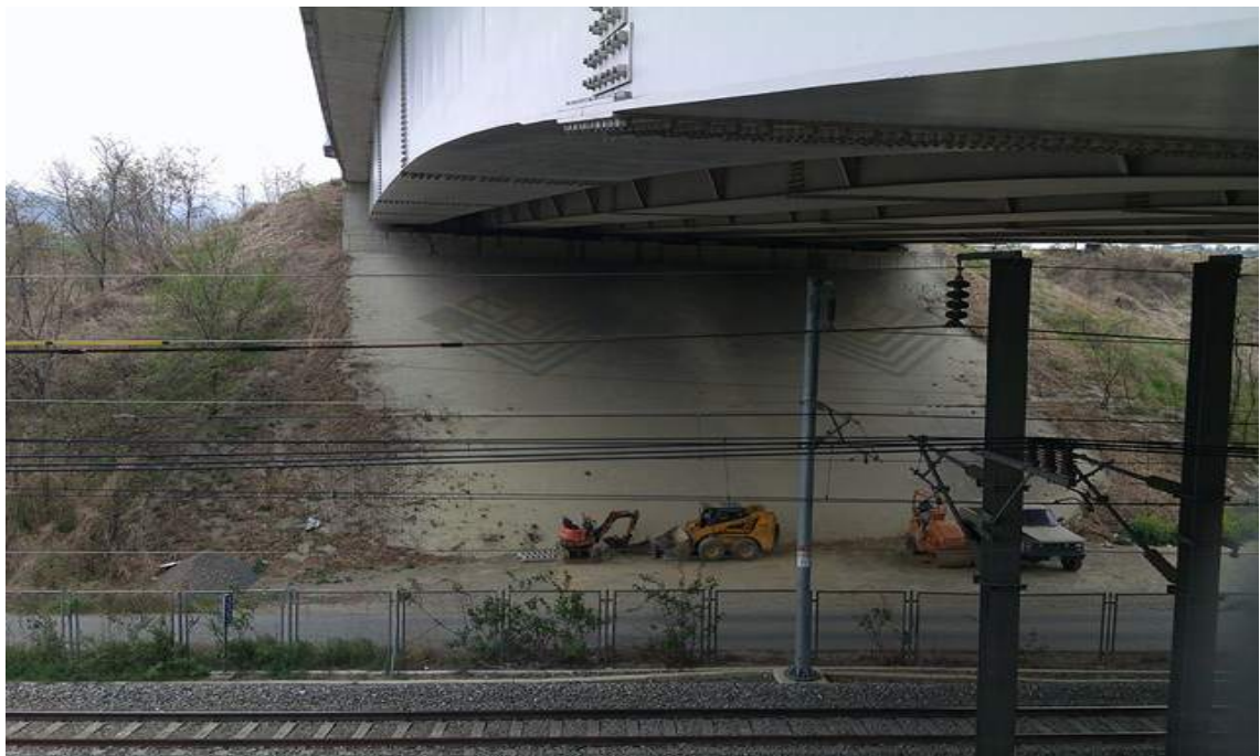
하부구조 전경 - 교대(A2)
