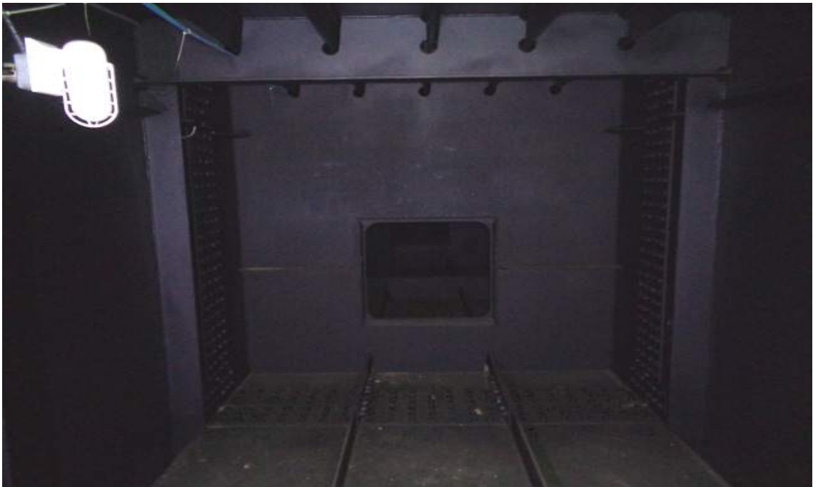
상부구조 전경 - 내부
